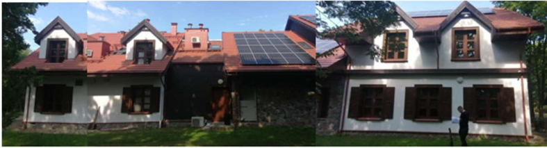
Elewacja tylna E
